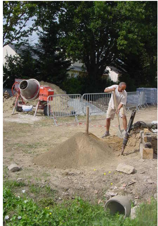
Philippe tamise la terre pour faire le thermique sous la dalle.
