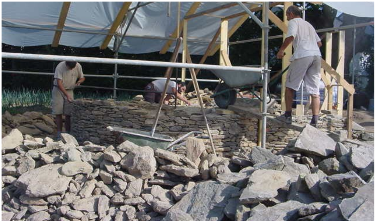
Marc et Clément montent les murs du four pendant que Philippe le remplit de thermique.
