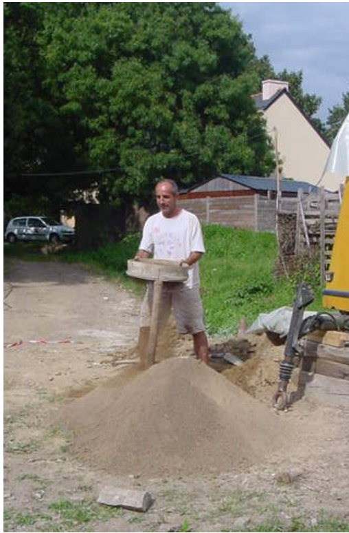
Philippe tamise la terre pour faire le thermique sous la dalle.
